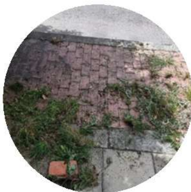
Retiro de maleza areas perimetrales en descuido por la UAESP
