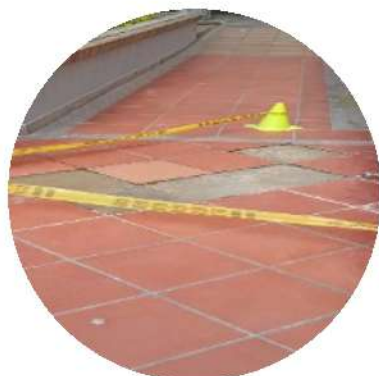
Remoción, cambio e instalación de baldosas fracturadas
