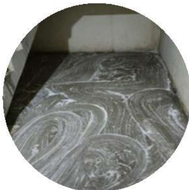
Jornada de Lavado escaleras de emergencia
