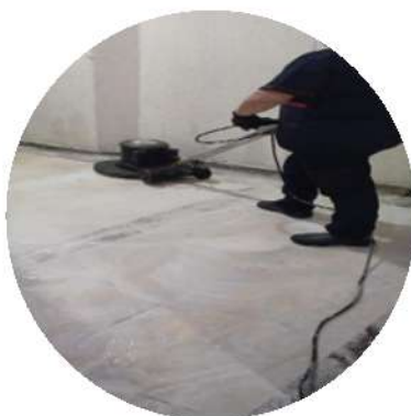
Brigada de Aseo desmanchado pisos y granito sótanos
