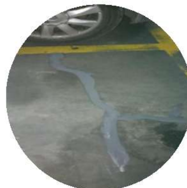
Sellado de grietas de la copropiedad
