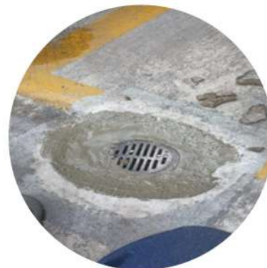
Sellamiento, sondeo y cambio de Sifonería
