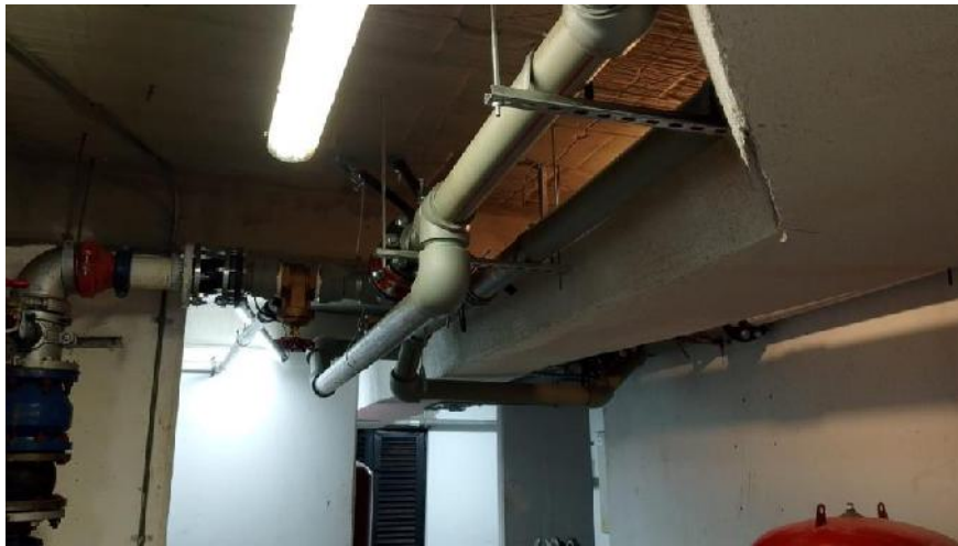
Imagen 25. Instalación de descargas generales hasta transición de PPR a Pvc-P, incluyendo válvulas y cheques de descarga general y by pass entre equipos.
