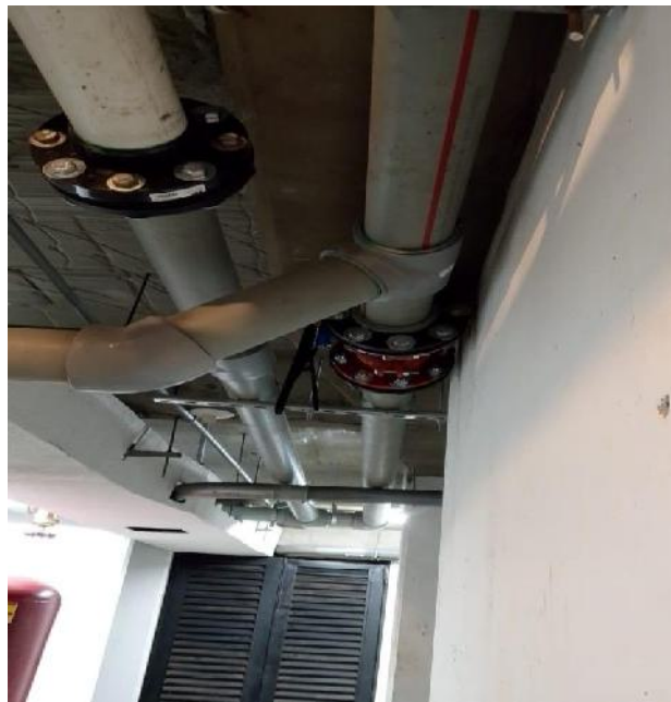
Imagen 27. Instalación de descargas generales hasta transición de PPR a Pvc-P, incluyendo válvulas y cheques de descarga general y by pass entre equipos.
