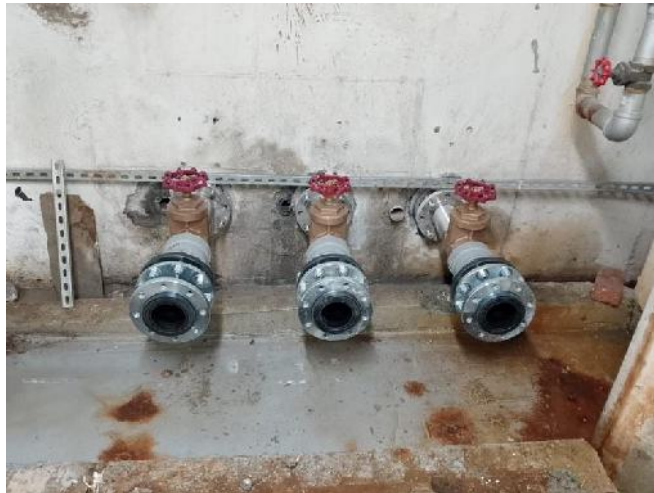
Imagen 30,31. Proceso de instalación de Niples Gatos y posicionamiento y conexión de bombas a de tanques.
