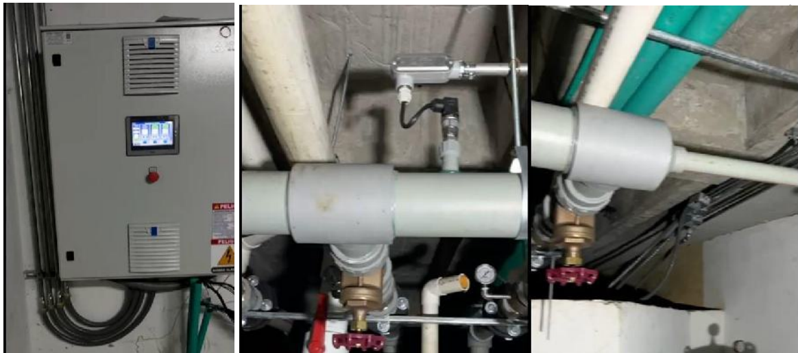
Imagen 12,13,14. Tablero operativo, conexionado de bombas y señales terminado.
