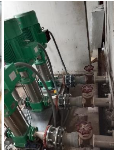
Imagen 30,31. Proceso de instalación de Niples Gatos y posicionamiento y conexión de bombas a de tanques.
