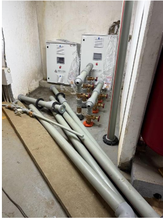
Imagen 20. Preensamble general para corte de agua y tableros de control para inicio de posicionamiento.
