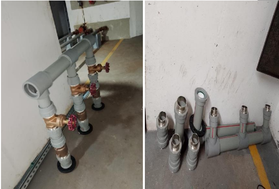
Imagen 1,2. Preensamble tubería.
