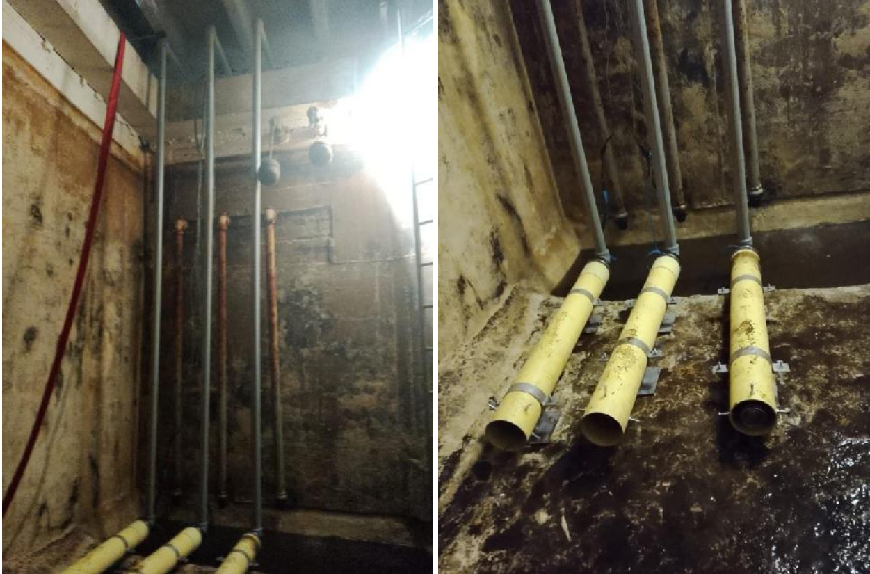
Imagen 15,16. Avance Instalación equipo de bombeo con conexión de bombas y salida de descarga individual del equipo de bombeo dentro de tanques.
