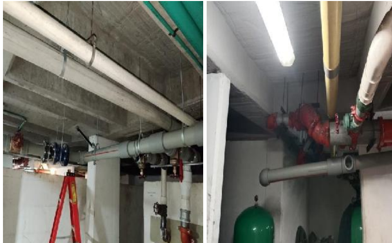
Imagen 5,6. Tubería preparada para conexión en corte de agua.
