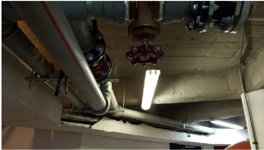
Imagen 26. Instalación de descargas generales hasta transición de PPR a Pvc-P, incluyendo válvulas y cheques de descarga general y by pass entre equipos.
