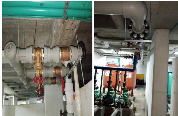
Imagen 3,4. Avance Instalación equipo de bombeo para conexión de bombas y salida de descarga general.
