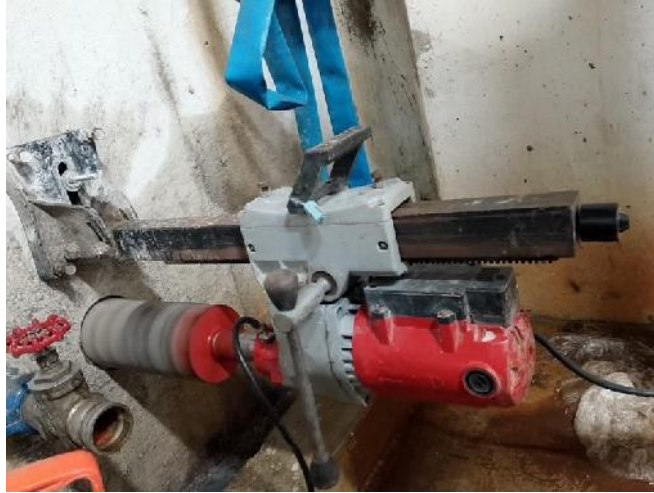
Imagen 28,29. Proceso de perfore de tanques para instalación de Niples tipo Gato.
