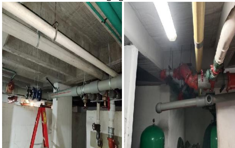
Imagen 5,6. Tubería preparada para conexión en corte de agua.
