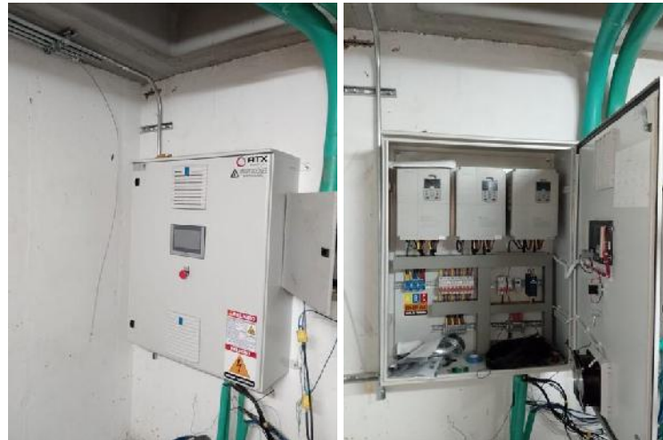
Imagen 9,10. Posicionamiento y conexonado de tablero de control.
