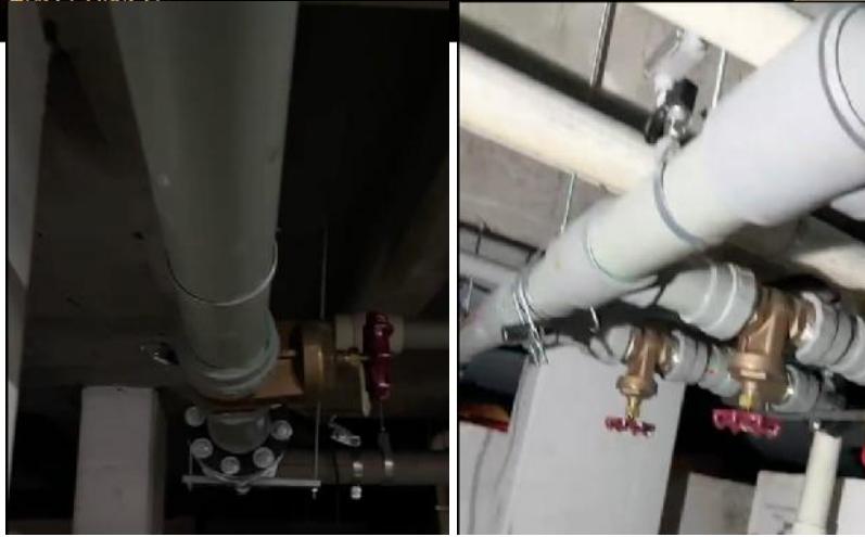
Imagen 7,8. Avance Instalación equipo de bombeo para conexión de bombas y salida de descarga general.
