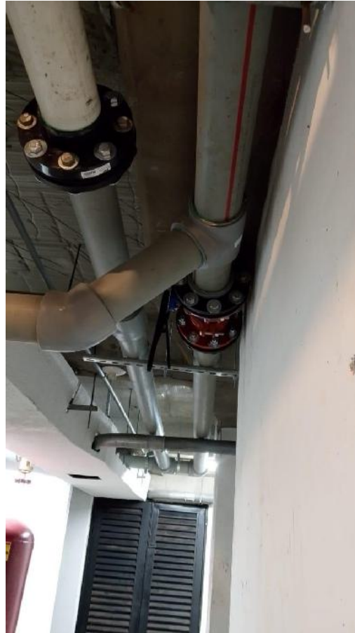
Imagen 26. Instalación de descargas generales hasta transición de PPR a Pvc-P, incluyendo válvulas y cheques de descarga general y by pass entre equipos.
