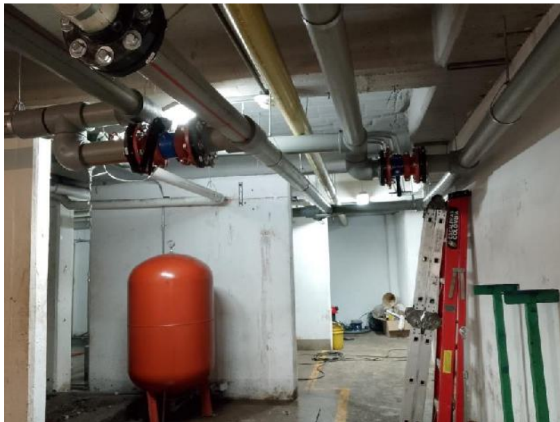
Imagen 18. Descargas generales terminadas, con instalación de by pass.
