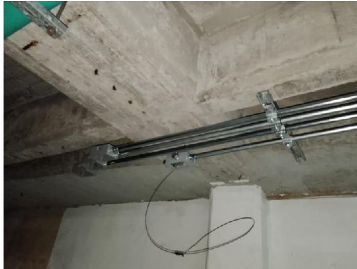
Imagen 11. Tendido de tubería y cableado para conexionado de motobombas.
