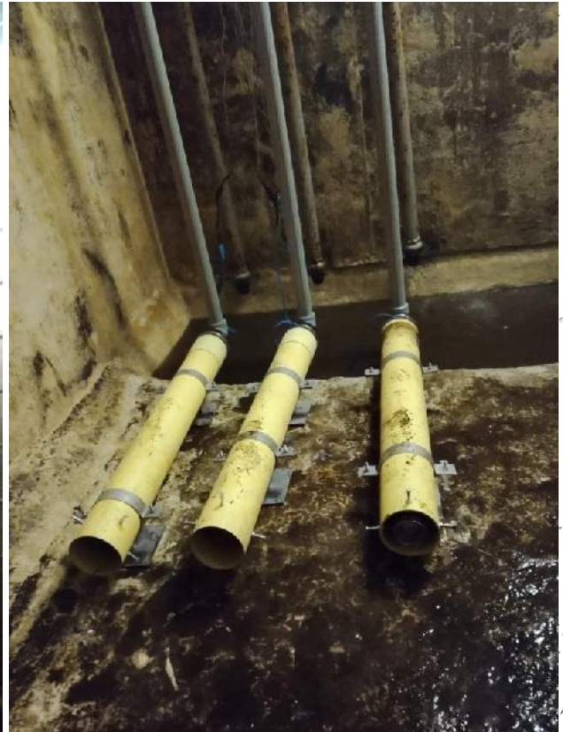
Imagen 15,16. Avance Instalación equipo de bombeo con conexión de bombas y salida de descarga individual del equipo de bombeo dentro de tanques.
