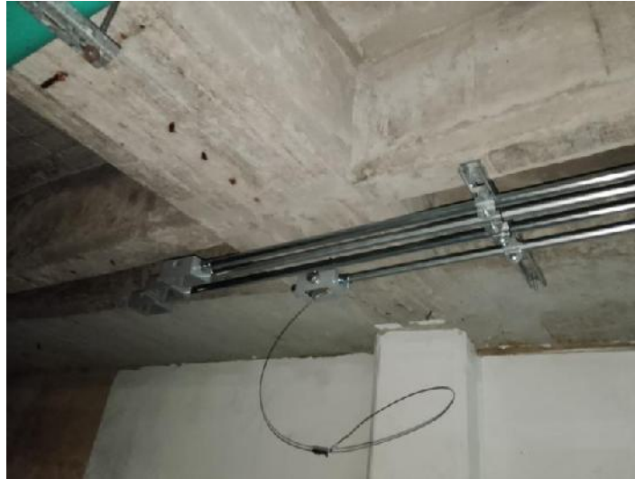
Imagen 11. Tendido de tubería y cableado para conexonado de motobombas.
