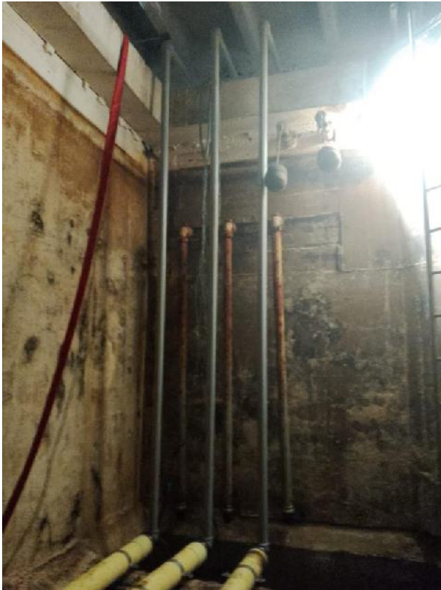
Imagen 15,16. Avance Instalación equipo de bombeo con conexión de bombas y salida de descarga individual del equipo de bombeo dentro de tanques.
