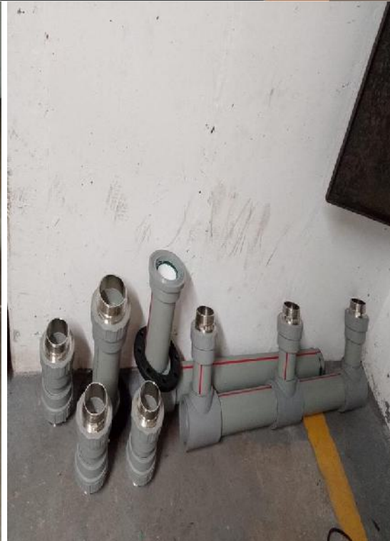
Imagen 1,2. Preensamble tubería.
