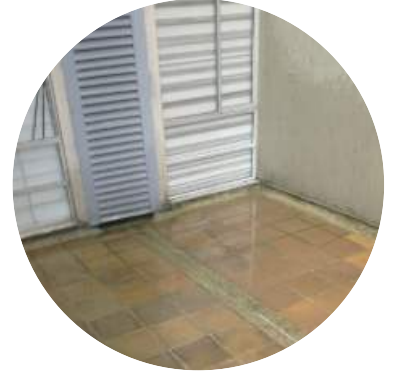
Lavado de descansadores de las torres
