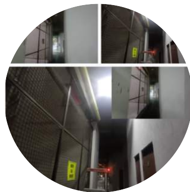
Cambio de farola en la bodega 291 294
