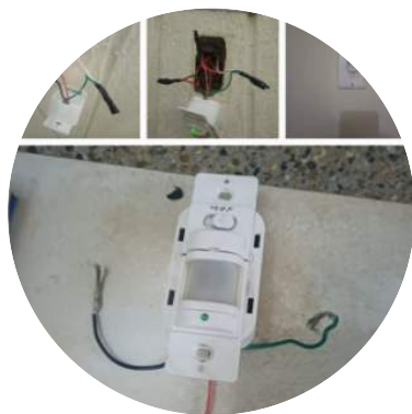
cambio de sensor en la torre 4 piso 14
