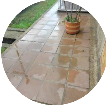
Lavado de descansadores de las torres
