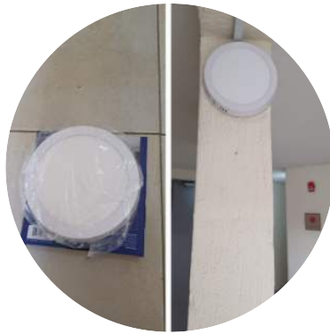
Cambio de farola en la torre 4 en la entrada de la torre
