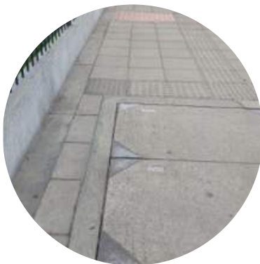
limpieza de perimetral externa
