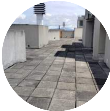
limpieza de cubiertas ( terrazas )
