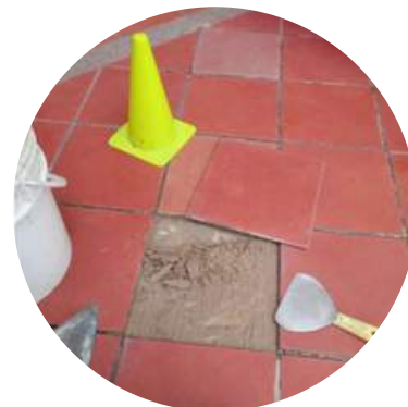
Cambio de tabletas paso peatonal zonas comunes
