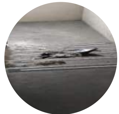
Brigada de barrido de escaleras de emergencia
