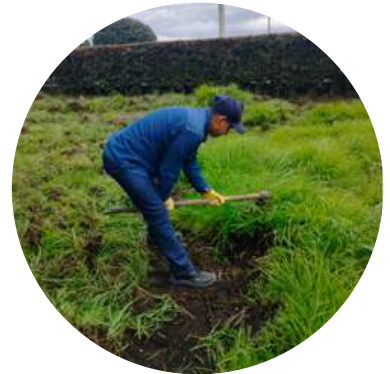
Adecuacion de cancha de futbol
