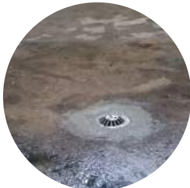
Cambio de rejilla de sifones
