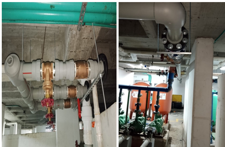
Imagen 3,4. Avance Instalación equipo de bombeo para conexión de bombas y salida de descarga general.
