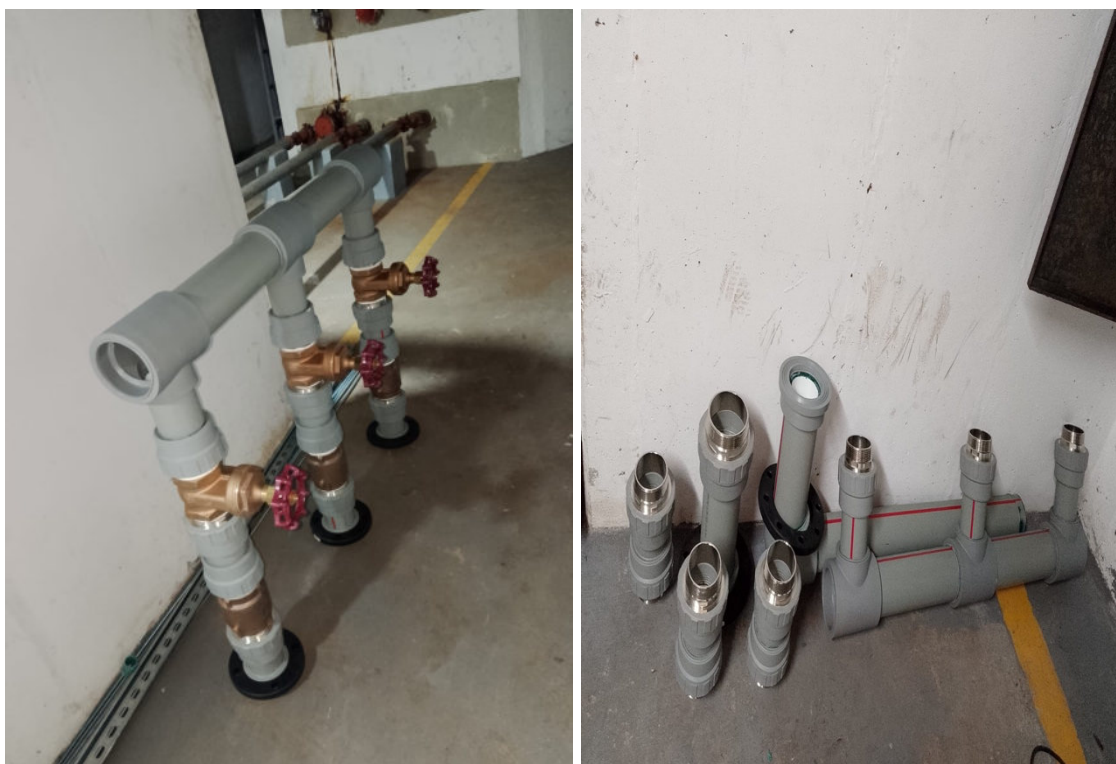
Imagen 1,2. Prensamblaje tubería.
