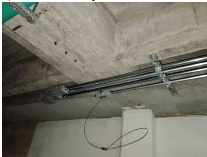
Imagen 9. Tendido de tubería y cableado para conexonado de motobombas.
