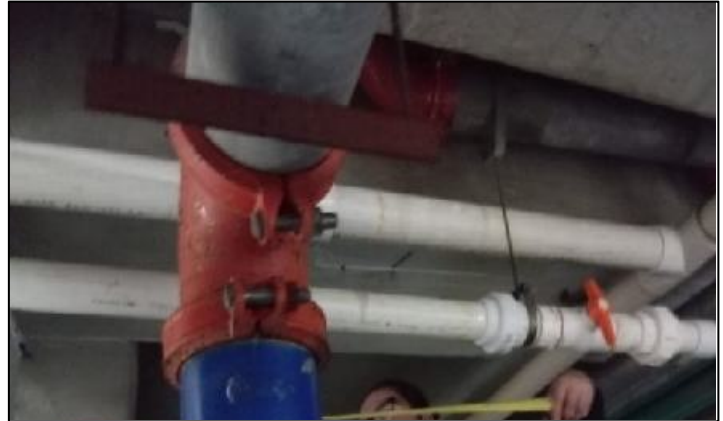
Tubería en PVC de traslado de agua al tanque.
