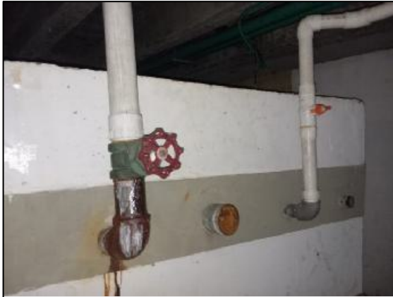
Tubería en PVC de traslado de agua al tanque.
